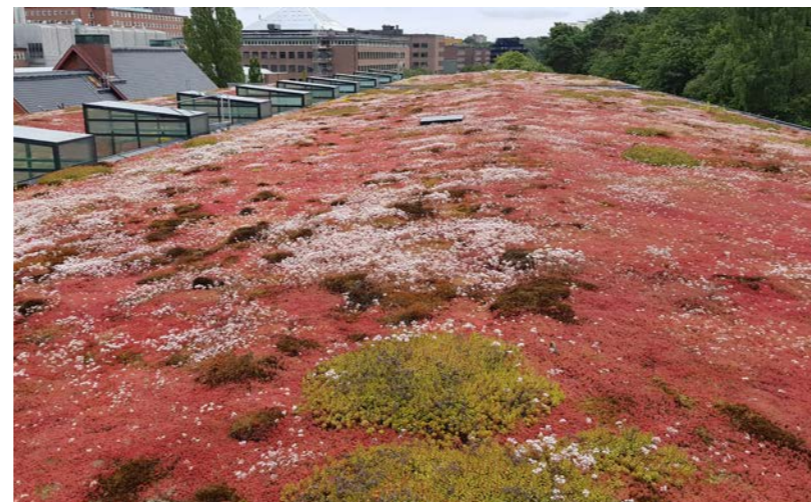
Sedum på det svävande taket fördröjer dagvatten och är vackert att se på
