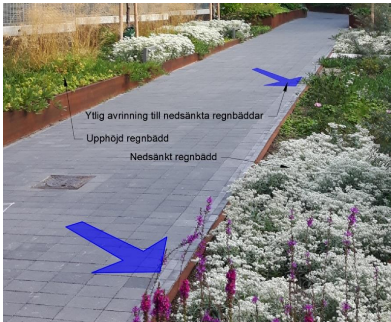
Figur 19 Illustration över en kombination av upphöjda respektive nedsänkta regnbäddar med ytlig avrinning från hårdgjord mark till nedsänkta grönytor
