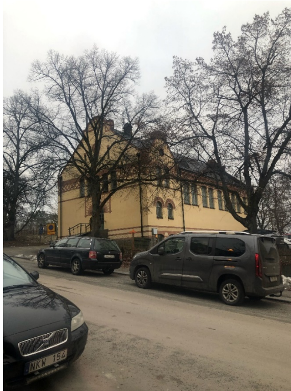
Bild som visar träden och framsidan av Gymnastikhuset sett från Kyrkogatan (Enköpings kommun).
